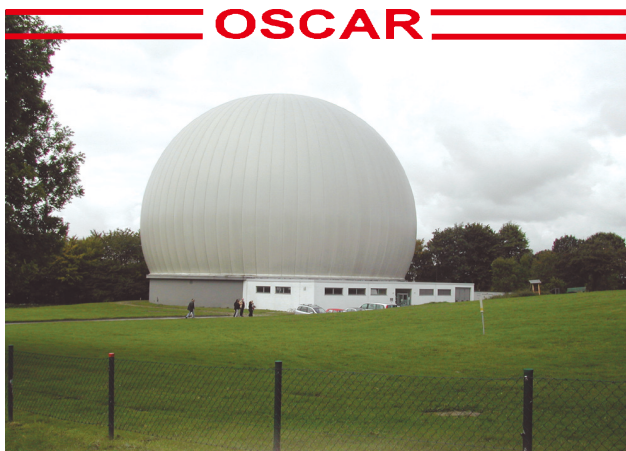
Obr. 1. Kopule dvacetimetrového radioteleskopu v Bochumi
